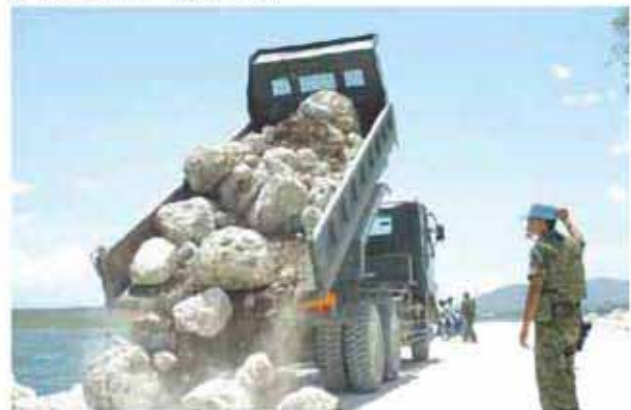
道路の補修作業を行う我が国要員
