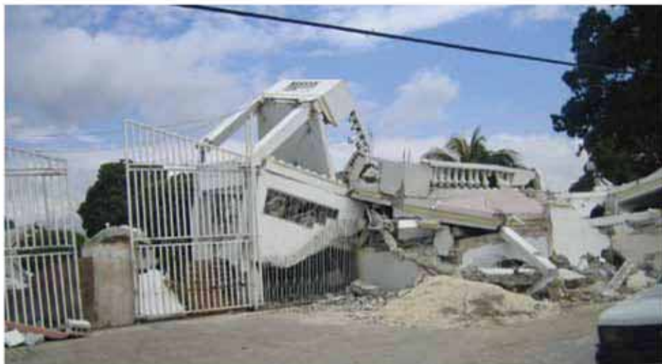
地震で倒壊した建物
