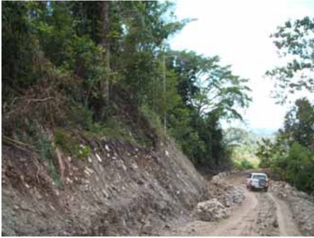
写真2 土砂崩れが心配な道路
